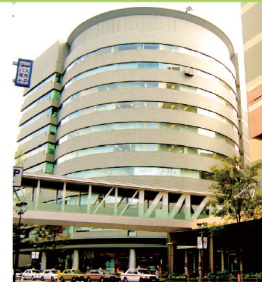
キャナルシティ・ ビジネスセンタービル
